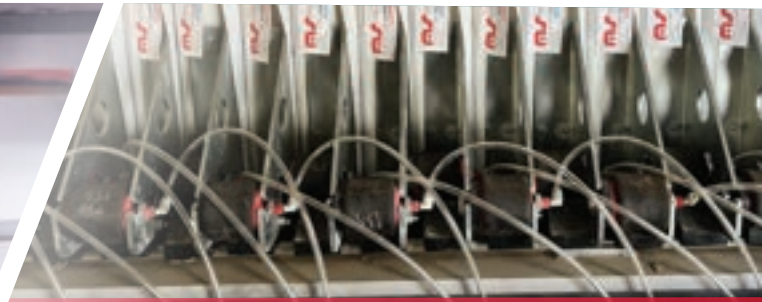
02 Débâtissage par vérins pneumatiques
